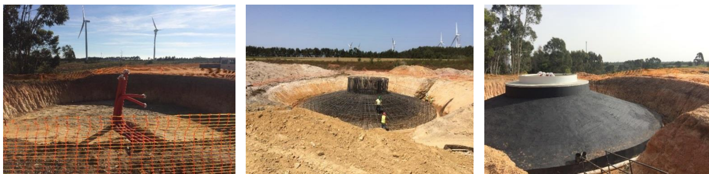
Figura v: Execução da fundação das torres dos aerogeradores (abertura do cabouco para a fundação e betonagem do maciço de fundação).
