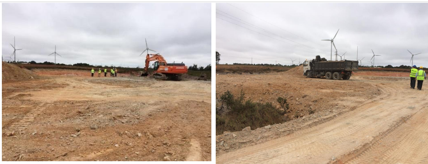
Figura iv: Trabalhos de decapagem e terraplanagens necessárias para a criação e beneficiação dos acessos e para a construção das plataformas.
